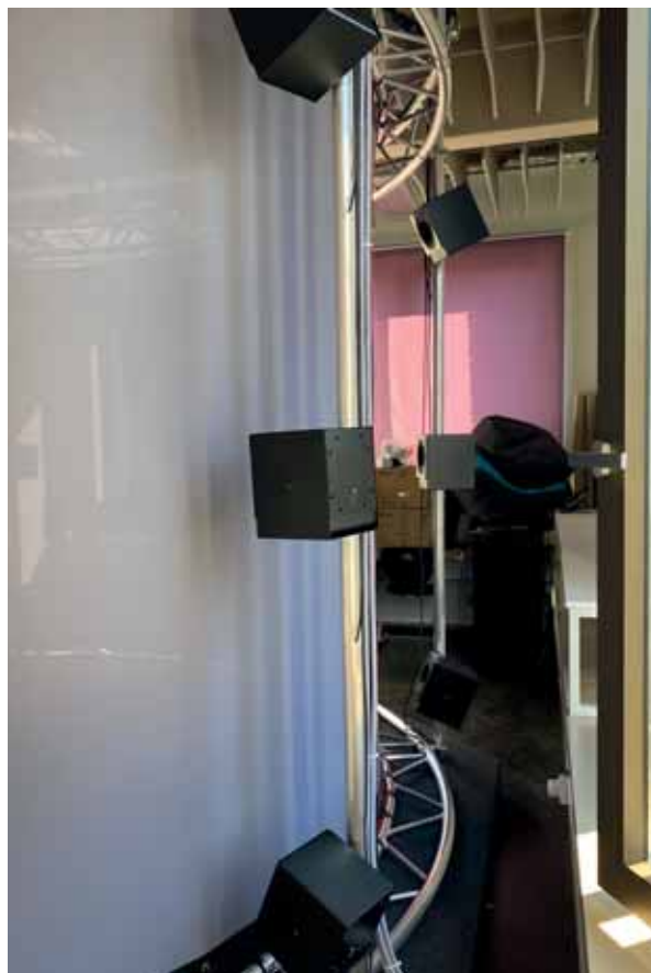
In 3 Ebenen sind die Lautsprecher angeordnet (oben, mittig, unten) zu- sätzlich noch in der Decke und im Boden des Domes.
