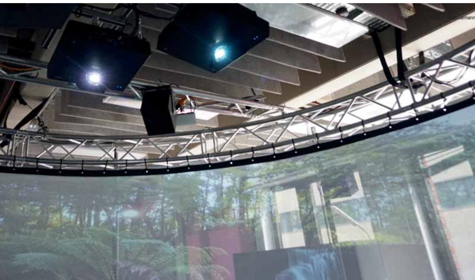
Realisiert ist die Konstruktion durch ein Trussing aus Kreisbögen, zwischen die die Leinwand zur Videoprojektion gespannt ist. Vier Videobeamer erzeugen eine 360°-Rundumprojektion.
